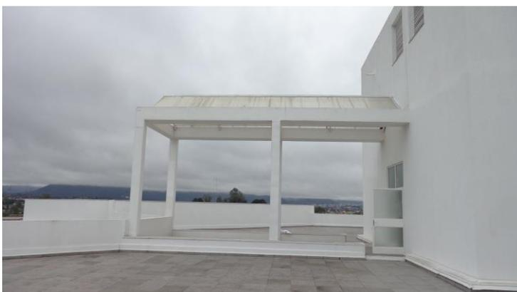
No terraço do bloco B, há vigas invertidas no piso que podem ser um dificultador para o acesso de pacientes, especialmente os com mobilidade reduzida. Para tornar o espaço plenamente utilizável, seria importante pensar em formas de contornar este problema, seja via elevação do piso ou utilização de rampas.
