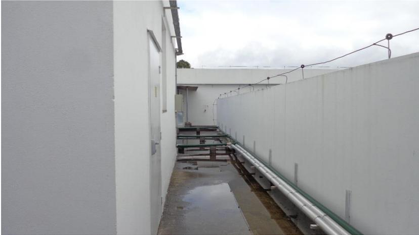
Na cobertura do bloco C, após as chuvas de maio, houve acúmulo de água na laje. Não foram observadas vias de drenagem para esta água e o isolamento não tem sido suficiente para impedir que haja infiltração para os andares inferiores. É necessária uma intervenção imediata, sob risco de danos ao acabamento de paredes, forros e pisos
