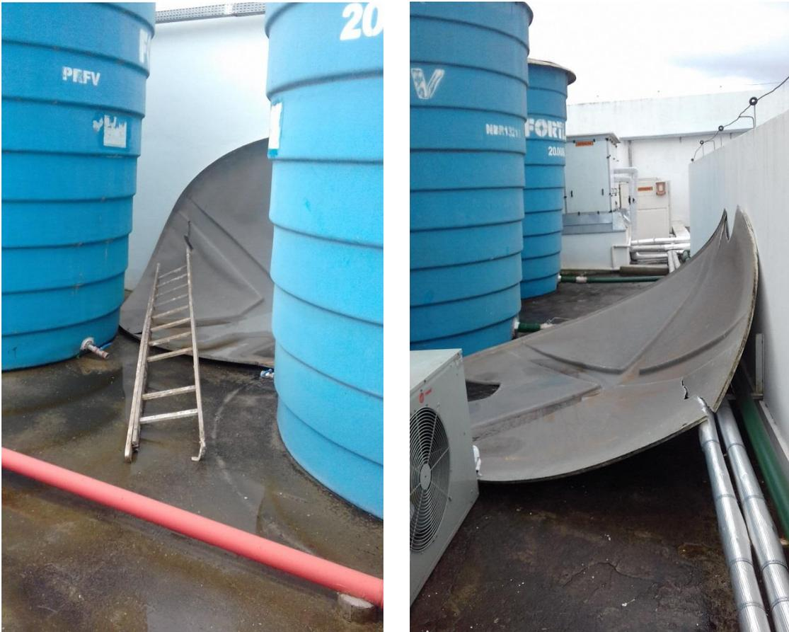
Na cobertura do bloco C, os ventos já arrancaram e danificaram as tampas de duas caixas d'água. Será necessária substituição e reforço na fixação.
